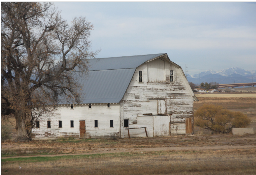
El establo Rietzenstein en el espacio abierto de Big Dry Creek se construyó en 1923 y se ha preservado bien.
