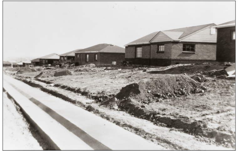
Casas bajo construcción en la subdivisión de Original Thornton.
