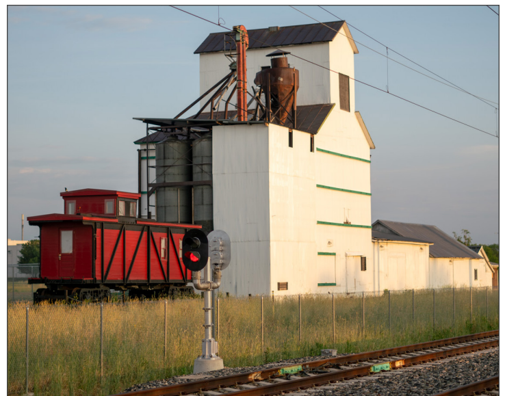
En sí, Eastlake es un recordatorio significativo del paisaje agrícola con el que inició Thornton y es la casa de este elevador de grano incluido en el Listado del Registro Nacional.
